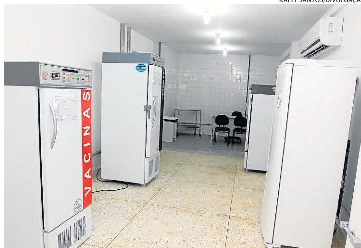
A unidade fica na Rua General Gurjão, no Centro de Caxias
